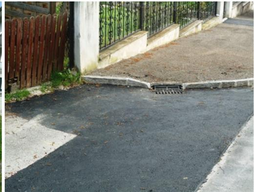
Danach begannen die Arbeiten in der **Lindabrunner Straße**: **Errichtung eines Gehsteiges, Verlegung einer Leerverrohrung und Bau eines Umkehrplatzes** für den öffentlichen Busverkehr. Diese Arbeiten sind beinahe fertig. Es folgen noch die Einfassungen der Grünanlagen auf der gegenüberliegenden Fahrbahnseite.
