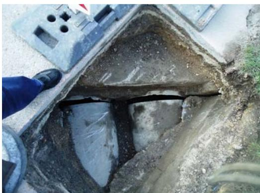
Zwei Betonrohre leiten den **Mandlingbach** unter den **Kippweg** in Grillenberg durch. Der Fahrbahnrand brach ein. Nach dem Aufgraben sah man, dass die Rohre nicht mehr dicht verlegt sind. Eine Betonummantelung gewährleistet den sicheren Abfluss.
