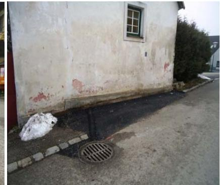
Die Fahrbahnoberfläche in **Pöllau** wurde aufgefräst. Nach der Planierung und Verdichtung wurde wieder eine 8 cm starke Asphaltsschicht aufgetragen. Ein neu verlegter Schrägbord leitet das Regenwasser sicher ab. Der obere Teil der **Zufahrt Kompostanlage Kuchner** wurde neu asphaltiert.
