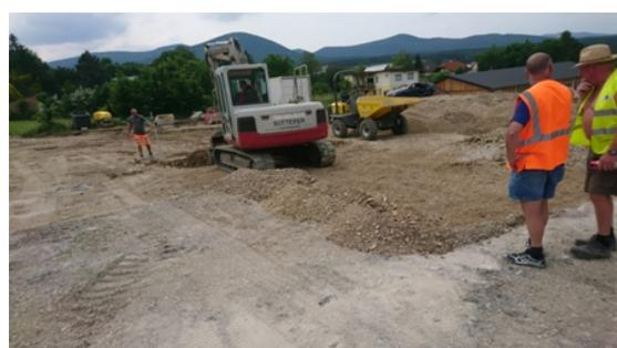
Das Starkregenereignis im September des Vorjahres hat den Asphaltbelag des **Ratzenbühels** unterspült und gehoben. Nach der Fertigstellung der Rückhaltebecken neben der Fahrbahn wurde der Güterweg mit einem neuen Asphaltbelag versehen.
