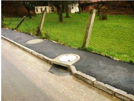
Froschmauleinlauf – Aigner Straße
