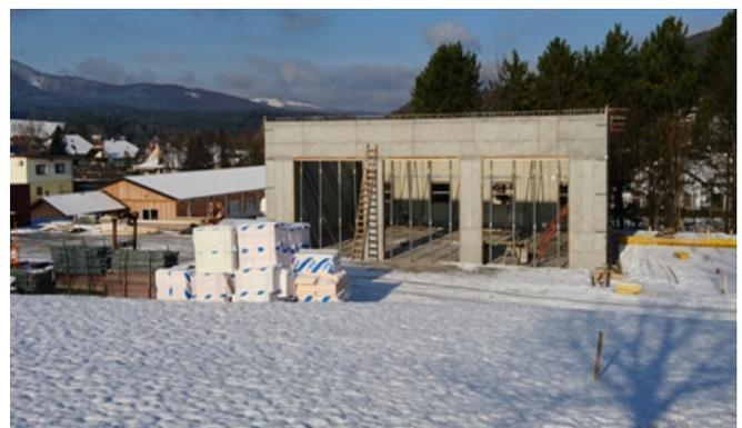
Der Bau des **Feuerwehrhauses für die FF Hernstein** schreitet flott voran. Ich danke allen Kameradinnen und Kameraden der Feuerwehr für ihren freiwilligen Arbeitseinsatz. Die Firma Lux Bau errichtet den Hallenbau mit Fertigelementen aus Beton.
