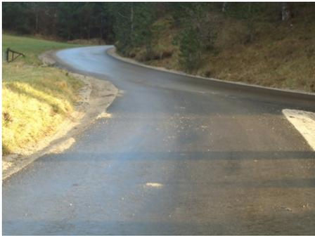
nach Pöllau und die Auffahrt zur Kompostanlage. Die alte Asphalt-schicht wurde aufgefäst und mit 15 cm Schotter aus dem Dolo-mitsandwerk verstärkt. Mit einer 10 cm dicken Asphalt-schicht wird die Fahr-bahn sicher jahrzehntelang problemlos befahrbar sein, die Regenwasserableitung wurde auch verbessert.
