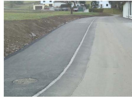
Ein ~ 20 m langes Straßenstück der **Sandackergasse** war in sehr schlechtem Bauzustand. Die Tragschicht wurde vollkommen entfernt, der Unterbau verbessert und diese Länge neu asphaltiert.
